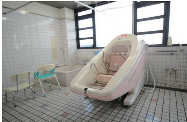
特殊浴槽装置導入
