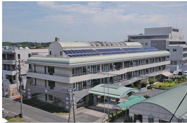
真空ガラス管形太陽集熱器の設置
