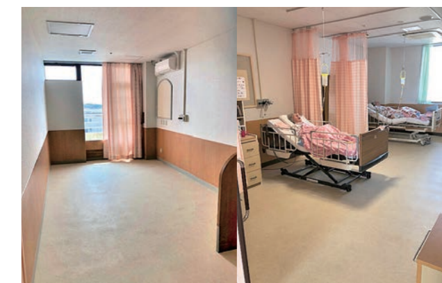
写真1 感染・看取り対応個室化改修
